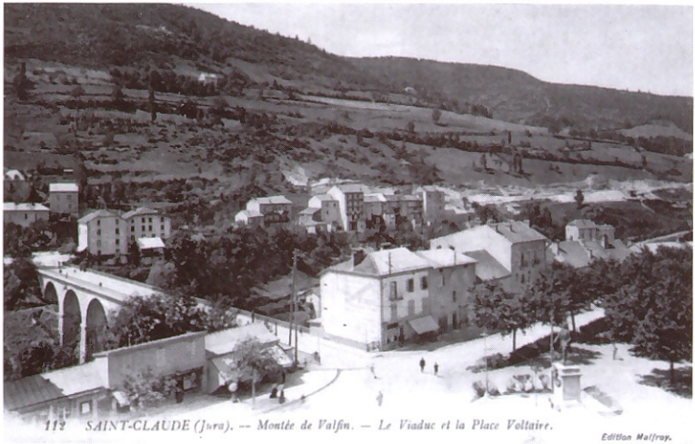
De l'autre côté du viaduc, les premières maisons de la rue Pasteur vers 1900.
