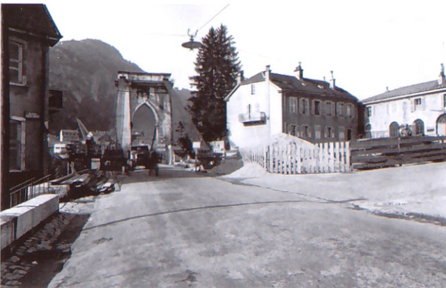
Début des travaux de remplacement du pont suspendu par le grand pont en 1939.
