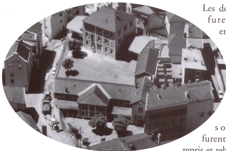
La rue des Ecoles en 1996 avant la démolition de la maternelle Rosset (Cl. R. Le Pennec).
