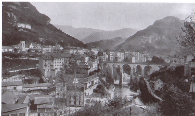
4918 SAINT-CLAUDE — LE VIADUC SUR LA BIENNE
