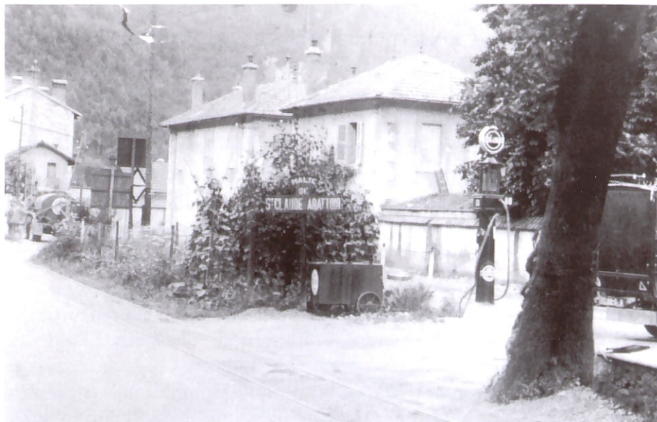
Station du tramway à Saint-Blaise vers 1930.
