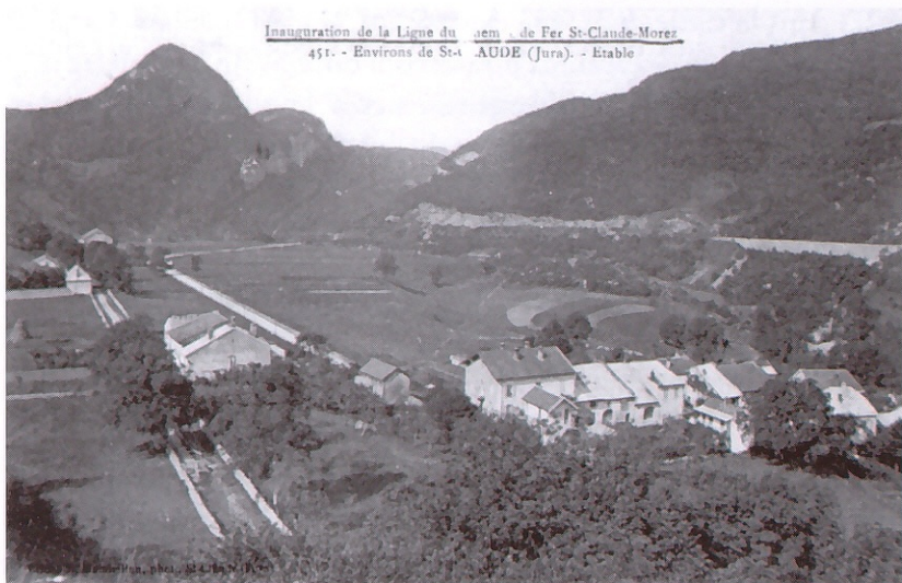
Les deux tracés superposés de la route de Lyon à Etables : à gauche l'ancien, au centre le nouveau.
