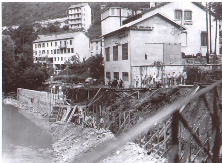
Construction d'égoûts au Miroir par les chômeurs en 1932.
