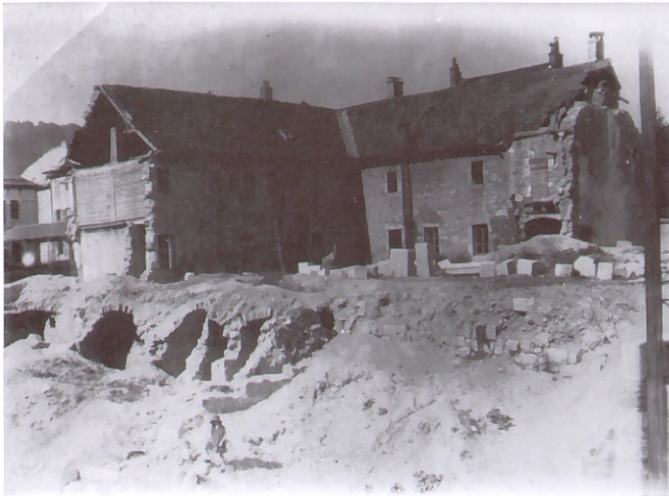
Démolition de l'ancien couvent des Capucins vers 1920.
