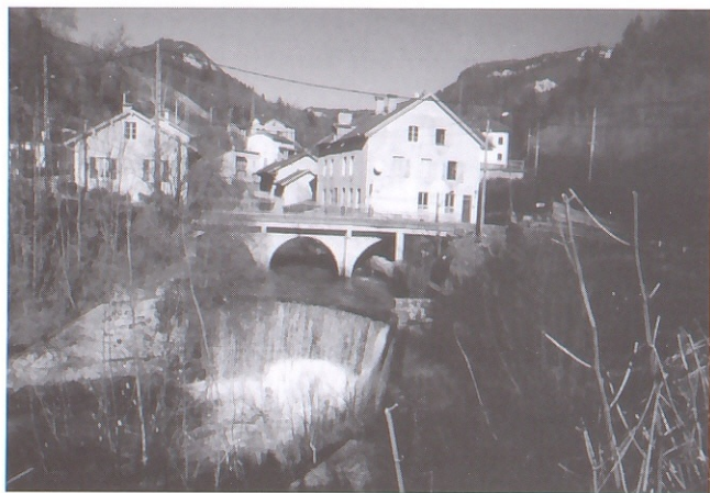
Le pont de la Serre en 2000 (Cl. R. Le Pennec).
