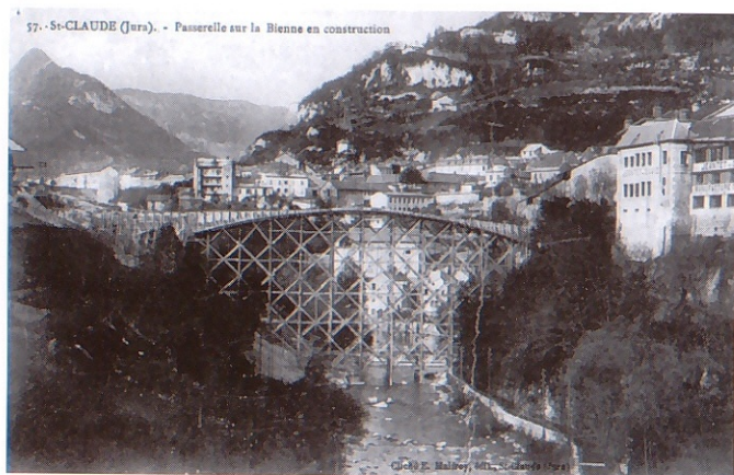
Construction du pont central en 1909.
