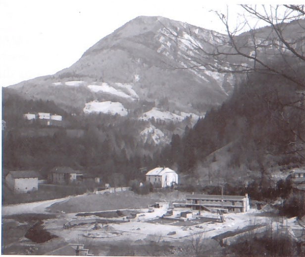
Construction de la piscine en 1963.
