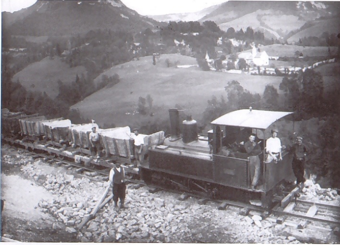
Construction de la ligne Saint-Claude-Morez vers 1910. Au fond, la Condamine.
