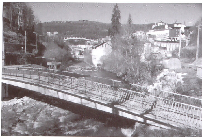
Trois ponts sur le Tacon en enfilade en 2000 : la passerelle du Tomachon, le pont de l'Hôpital et le grand pont.
