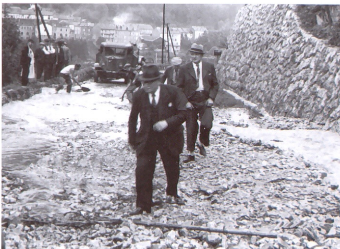
Route de Valfin après un orage dévastateur en 1939. Au premier plan, le député Arsène Gros.
