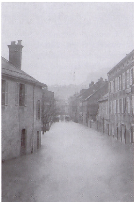
Inondation de 1897 dans la rue du Faubourg Marcel (cl. Mandrillon).
