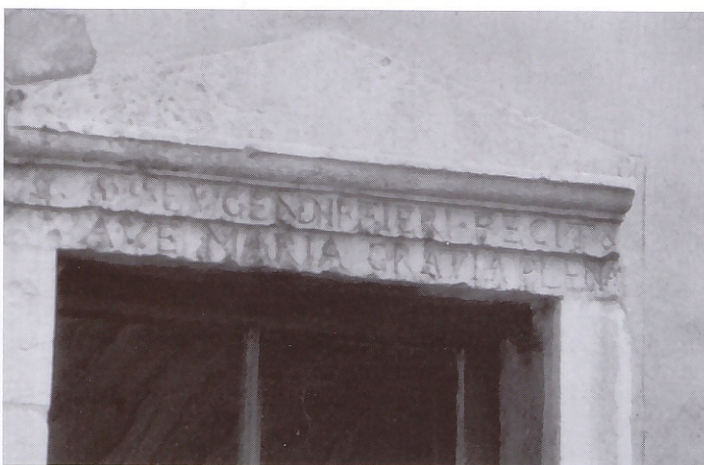
Linteau provenant de l'ancienne chapelle des Pénitents Blancs place du Château (cl. R. Le Pennec).
