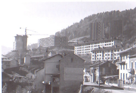
La zone d'habitation des Avignonnets en construction vers 1970.
