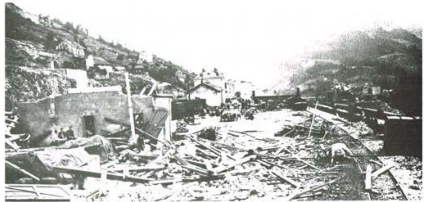
La gare de marchandises ravagée par le cyclone, telle que premiers habitants du Grand Plan (maison Pierre Salvin) ont pu la voir la mardi 19 août 1890
