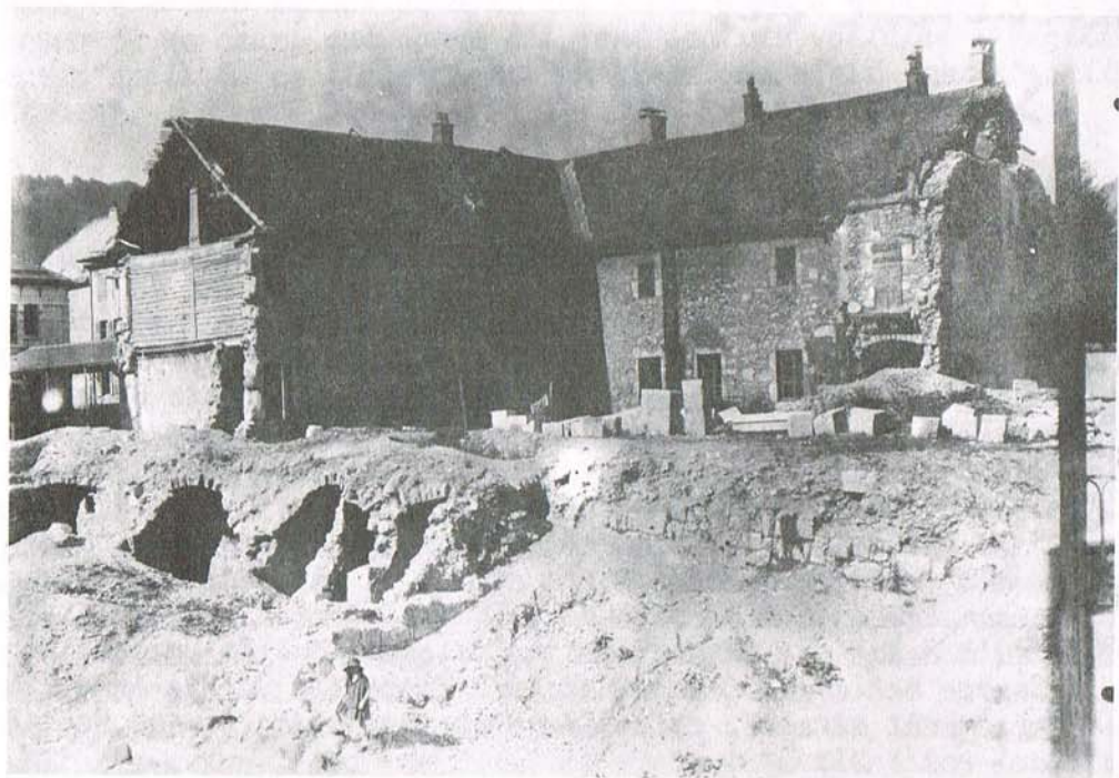
Le vieux Collège en 1919 et ses caves voûtées.
